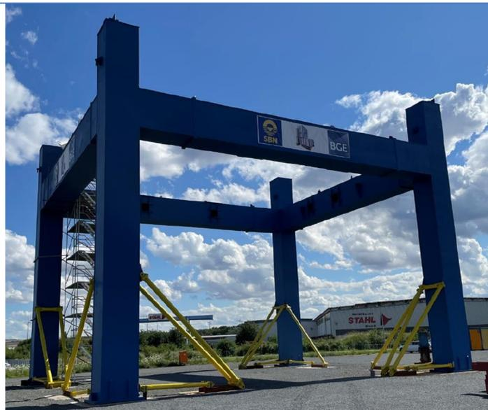
Der Förderturmteil für Konrad 2, den Sie hier sehen, wurde andernorts hergestellt. Diese Stahlkonstruktion wird eine Gesamthöhe von 42 m haben. Nach dem Transport und seiner Errichtung wird dieser Turm die Grundlage für die Beförderung der Abfälle von der Biosphäre in die tiefen geologischen Schichten sein.
