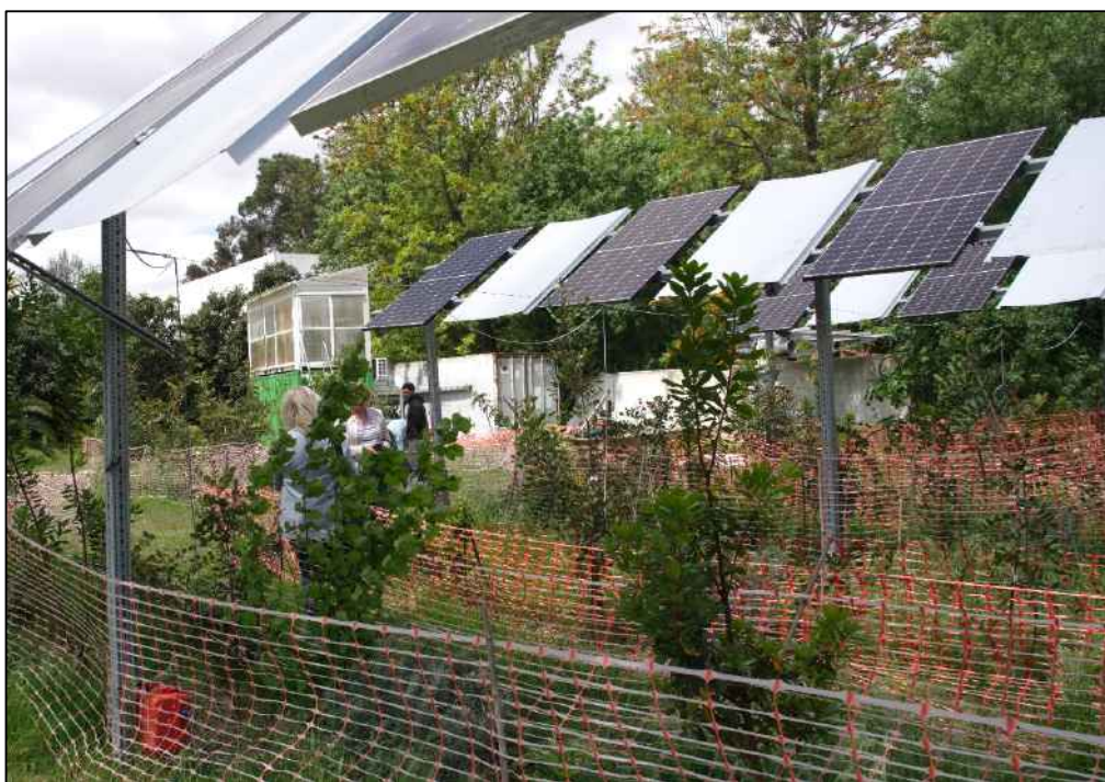
Kernbereich des Solar Campus mit drei Agri-PV-Anlagenreihen und einer Pflanzung ohne Beschattung durch eine Agri-PV-Anlage links im Hintergrund
