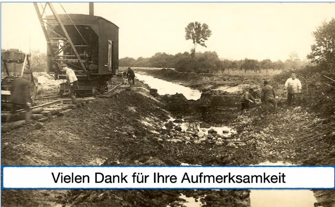
Hier sehen Sie ein Bild des Ausbaus, der von 1928 bis 1931 durchgeführt wurde. Zugegebenermaßen handelt es sich nicht um einen Deichbau, sondern um den Ausbau der Este. Die waren mit einem Dampfbagger schneller als wir heute, und zwar deutlich!
