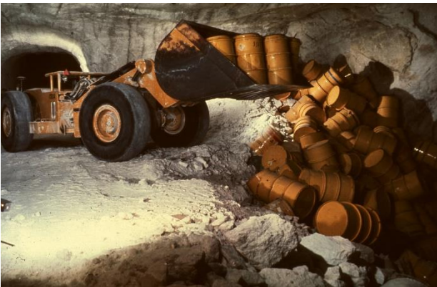
Abbildung 1: Ein Radlader kippt im Jahr 1975 Fässer mit radioaktivem Abfall in eine Einlagerungskammer der Schachanlage Asse II ab, Foto: BGE
