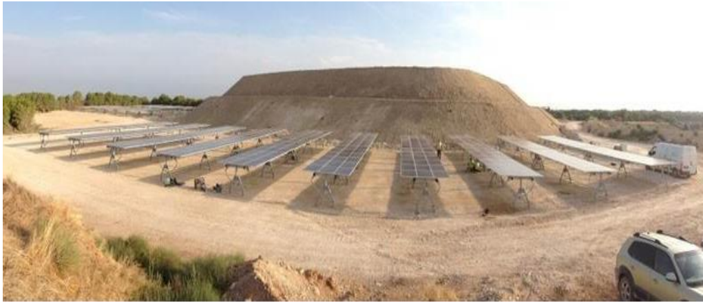
Presurització de la xarxa de reg de la Bassanova amb plaques solars
