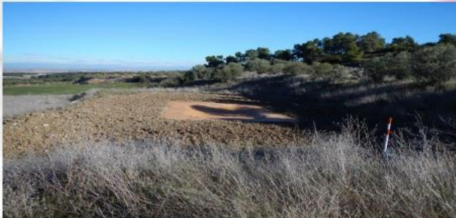
Basses d'amfibis en construcció
