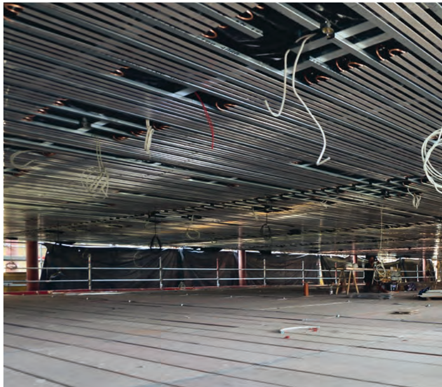
Klima- und Lüftungstechnik im Doppelboden des Plenarsaals entstehen
