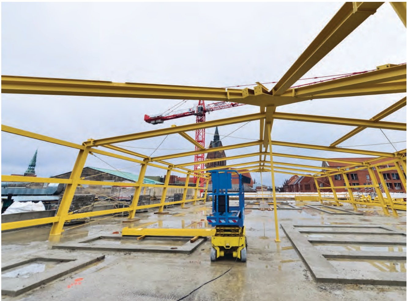
Die neue Dachlaterne entsteht
