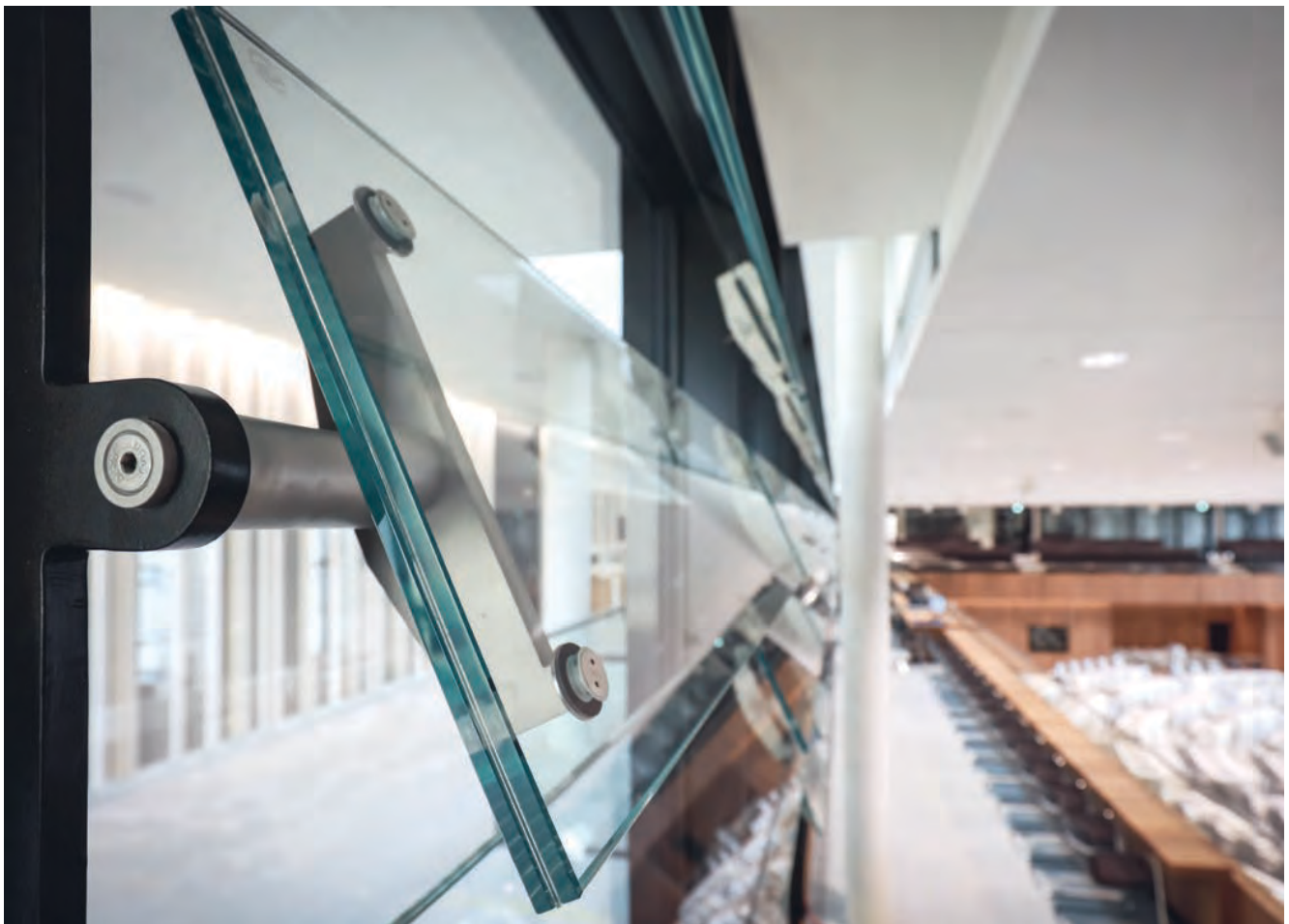
Schallbrecher: Glaslamellen im Plenarsaal
