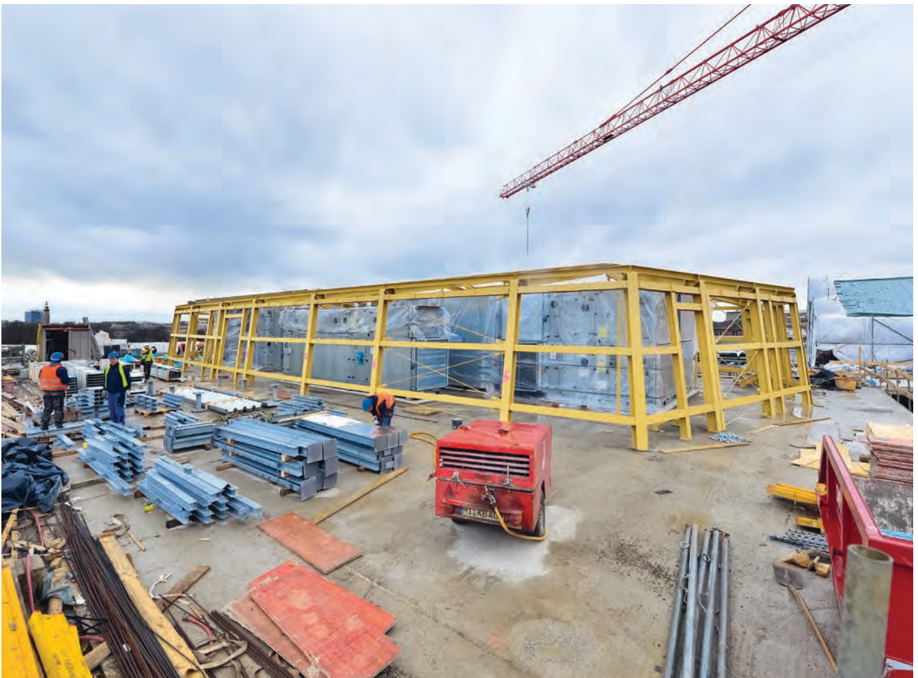
Die Dachlaterne integriert modernste Lüftungs- und Klimatechnik
