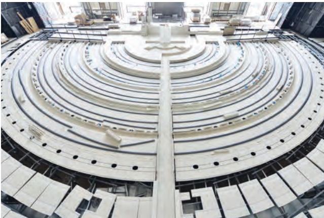
Kühl- und Heizdecken garantieren die energieeffiziente Klimatisierung
