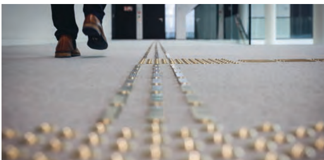
Inklusive Wegweiser: Ein Leitsystem hilft Sehbehinderten bei der Orientierung
