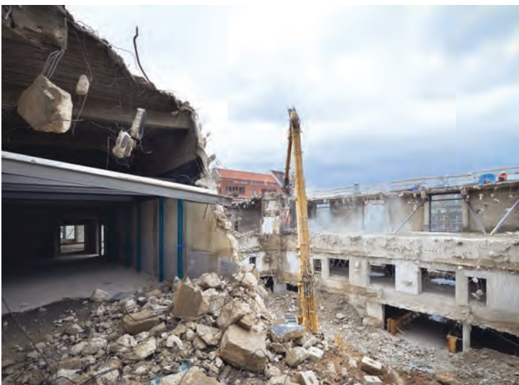
Abriss bis auf die Außenmauern
