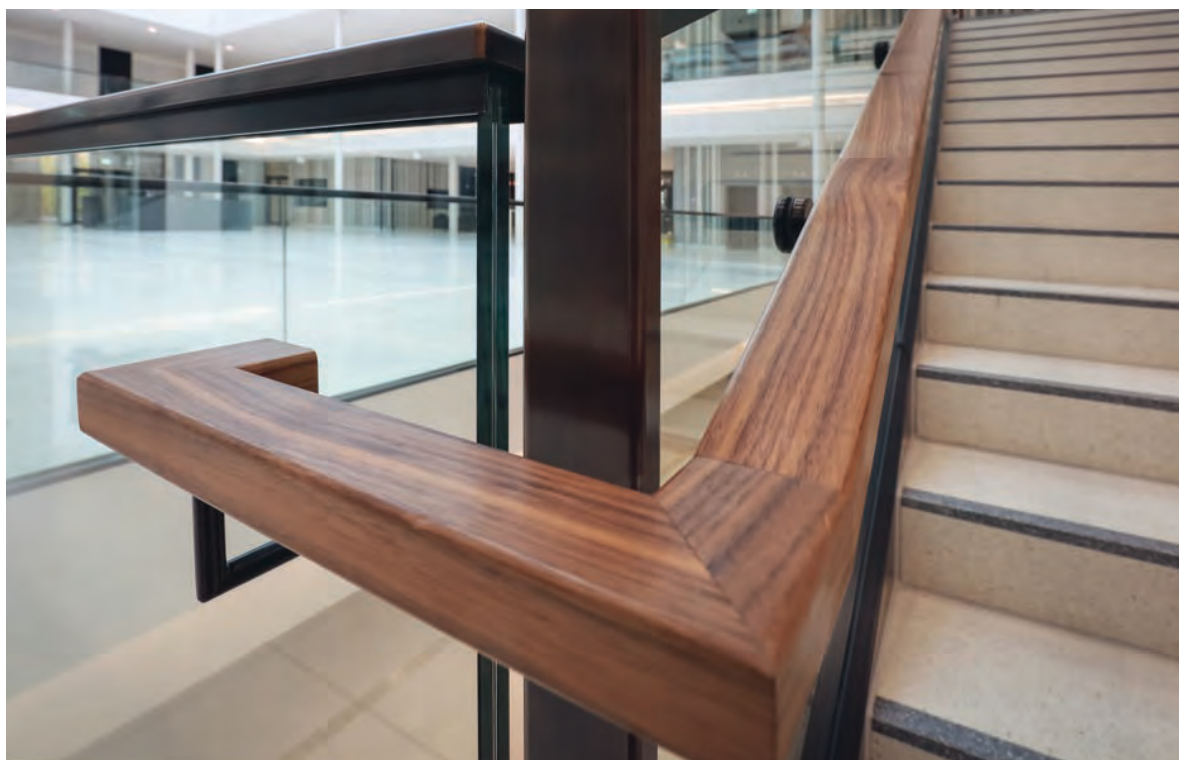
Tradition und Moderne vereint: Die kupferummantelten Handläufe Oesterlens wurden um umlaufende Handläufe ergänzt
