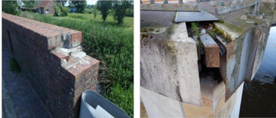
Abbildung 16: *Schadhaftes Mauerwerk und fehlendes Abdeckblech an Übergangskonstruktion (Quelle: LRH)*
