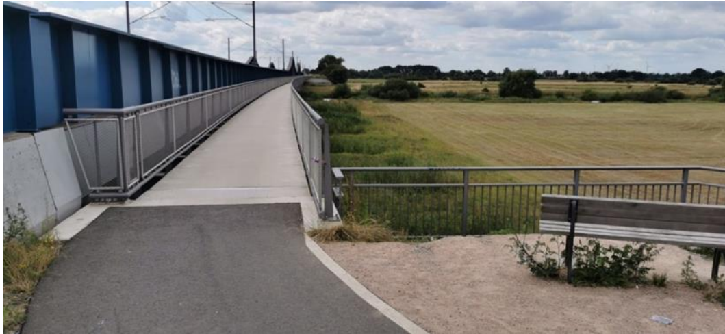
Ansicht 12: Radbrücke angehängt an Eisenbahnbrücke über die Aller 67
