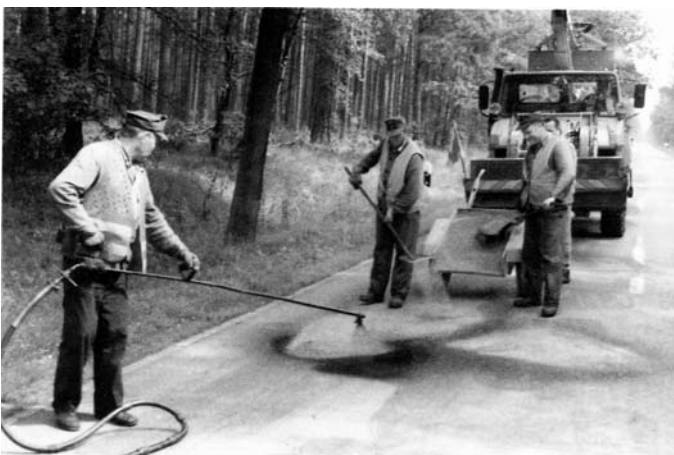
1989 Flickarbeiten mit Bitumen- emulsion aus der Bindemit- telspritzmaschine mit Trockensplitt
