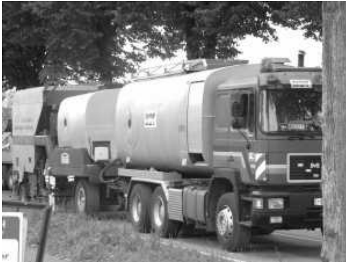
Flickarbeiten mit Reparaturzug
