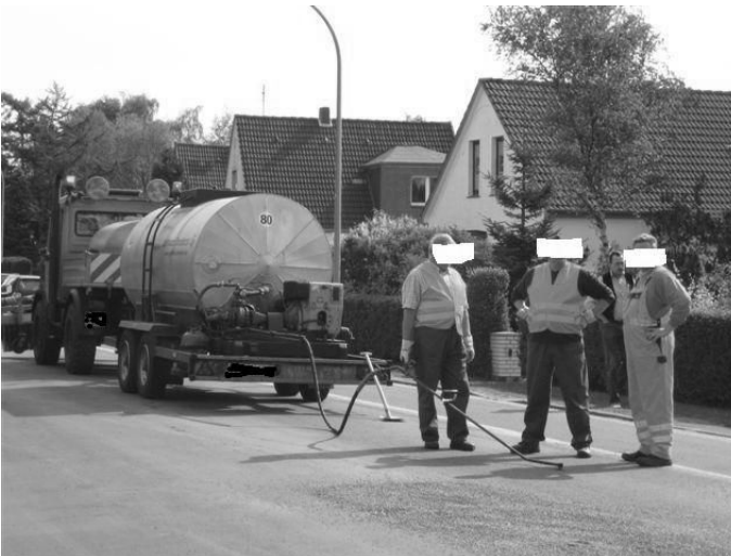
2006 Flickarbeiten mit Bitumen- emulsion aus angemieteten Servicetank und mit Trockensplitt 5 Straßenwärter 3 Fahrzeuge
