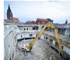
↑ Abrissarbeiten am alten Plenarsaal, Tom Figiel
